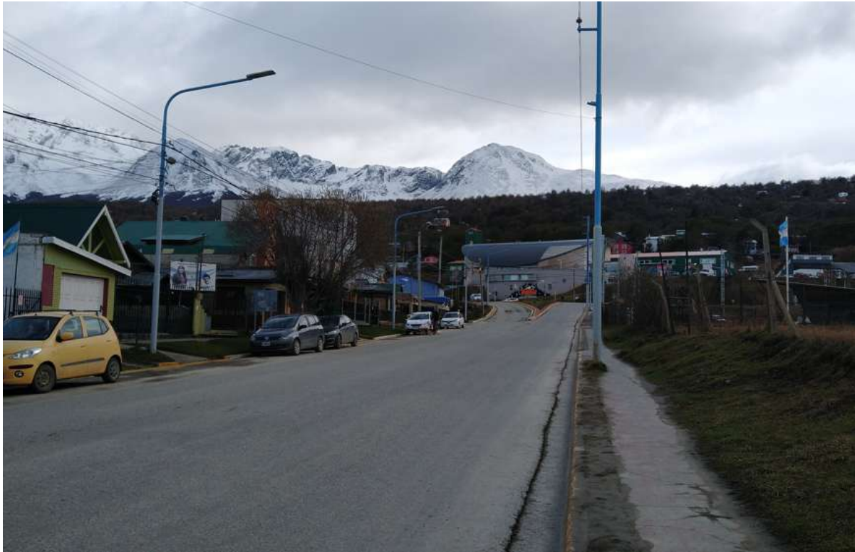
Figura 23. Calle Yaganes, hacia la rotonda del Polivalente. Foto relevada por la Municipalidad.
