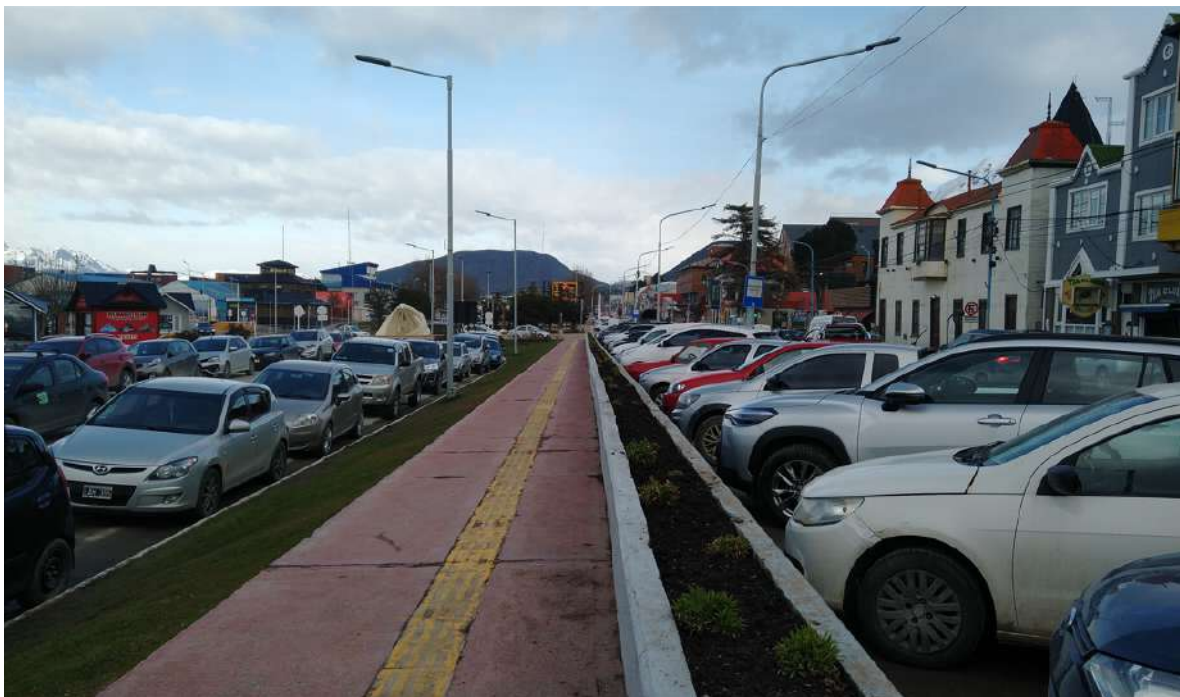
Figura 18. Zona de paso bajo evaluación para el tránsito seguro de bicicletas en Av. Maipú, entre Roca y Godoy. Foto relevada por la Municipalidad.
